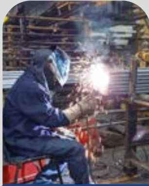
Corte de barras y vigas (Sierra y Oxicorte)
