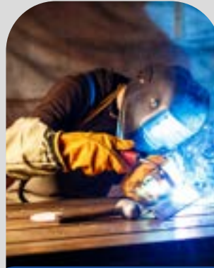
Soldadura y pintura
